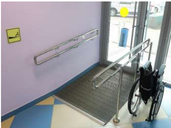
Пандус (внутри здания).
